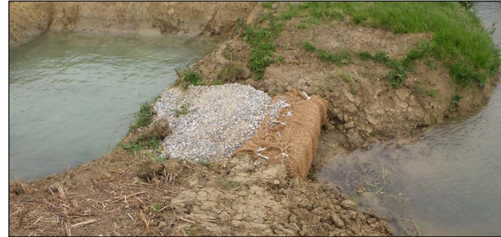
Figure 22 : Illustration d'un dispositif d'assainissement provisoire en phase chantier (filtre à gravier doublé d'un filtre à paille)
